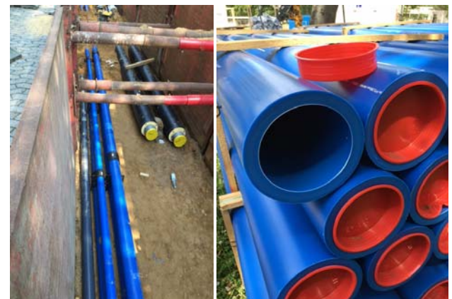
Kälteleitung und Rohrpostverlegung im gemeinsamen Graben
