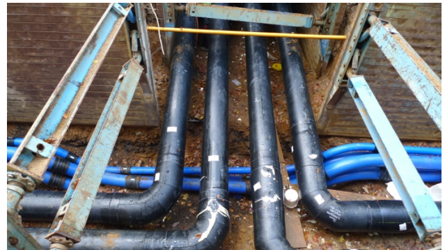
Verlegung der Fernwärmeleitung und Wasserleitung
