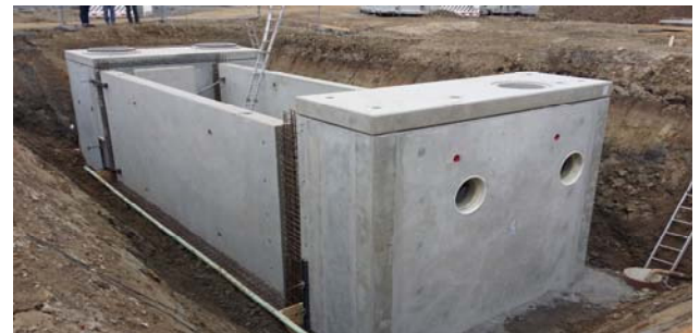
(RKB, Baugrube mit Rohbau)
