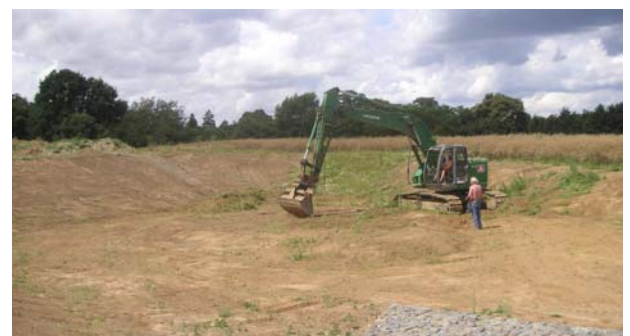
Mulde mit darunterliegende Rigole
