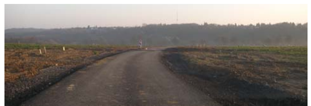
Baustraße in Asphaltbauweise
