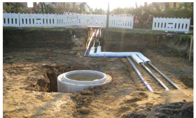
Neubau Fernwärme, Wasserleitung, Kanalisation
