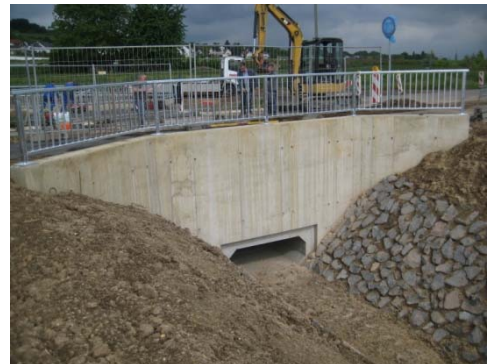
Flügelstützmauer mit Böschungssicherung mit Wasserbausteinen
