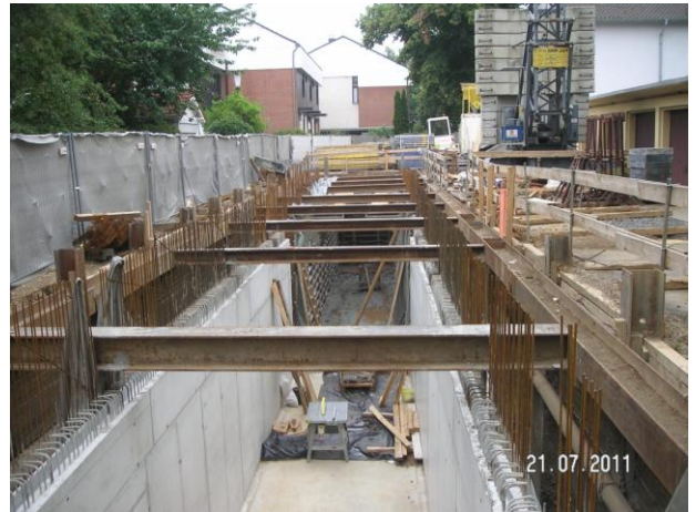
Rückhaltebecken in Ortbetonbauweise, Länge ca. 38 m
