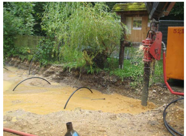
Einbringung der Spülfilteranlage
