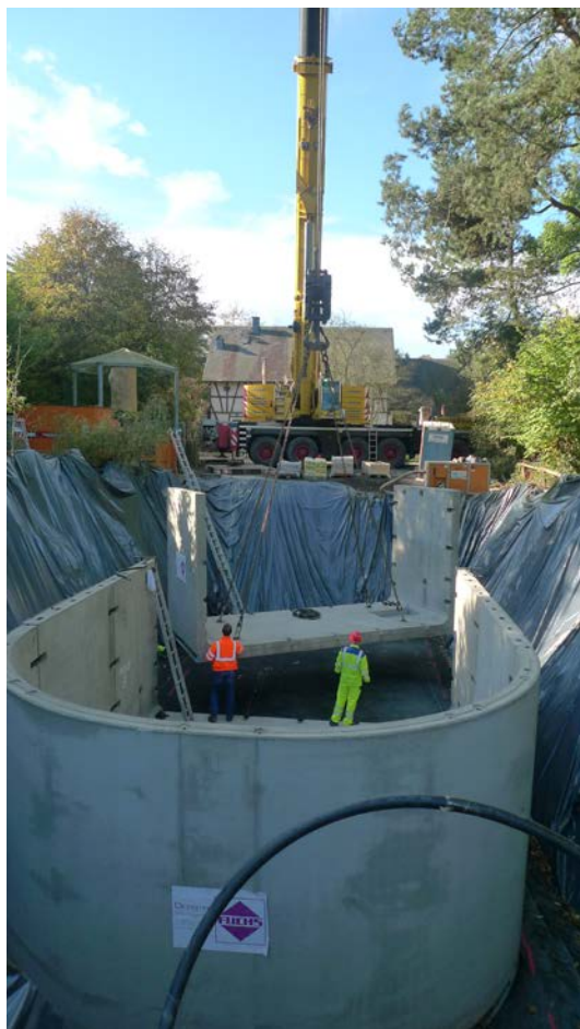
Einbringung des Löschwasserbehälters
