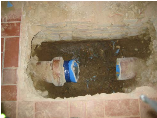
Kopfloch für Sanierung mit Schlauchliner
