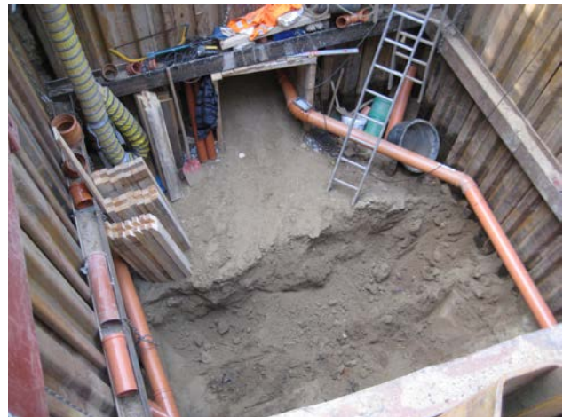
Baugrube Bauwerk Pumpwerk
