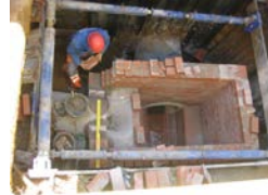
Verlegung Kanal und Wasserleitung
