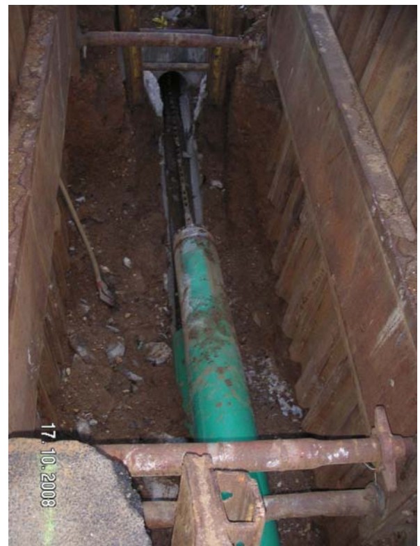
Einziehgrube TIP-Verfahren
