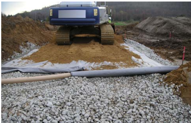
Straßenbau industrielle Schwerlastfläche
