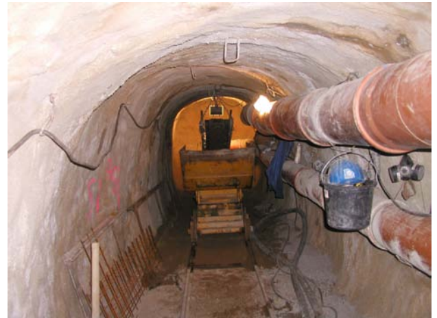
Stollenquerschnitt mit Wasserhaltung und Be- und Entlüftung
