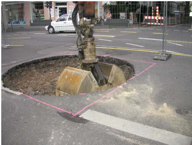
Startgrube für den Stollenbau im Kreuzungsbereich Bonner-Talweg
